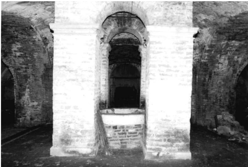
Fig. 7: Foto del vero pozzo che nasce al piano terreno dell'edificio e pesca l'acqua da una cisterna sottostante che raccoglie le acque piovane che lì convergono da tutto il fabbricato
