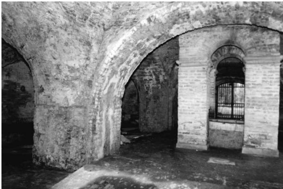
Fig. 8: Uno dei quattro enormi pilastri che sostengono il cortile pensile, tutti posizionati in asse alle caditoie dei quattro campi del cortile soprastante.
