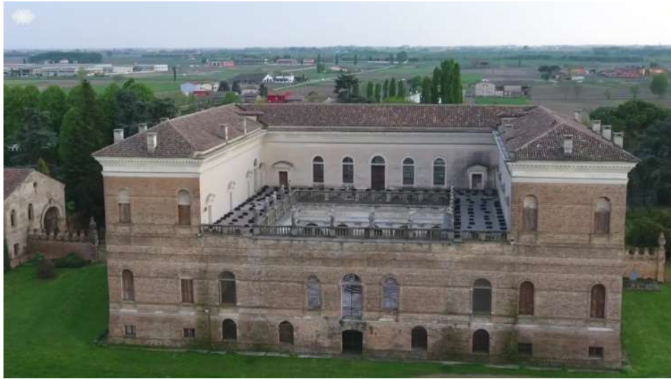
fig. 2a - retro (prospetto nord) di villa Garzoni
